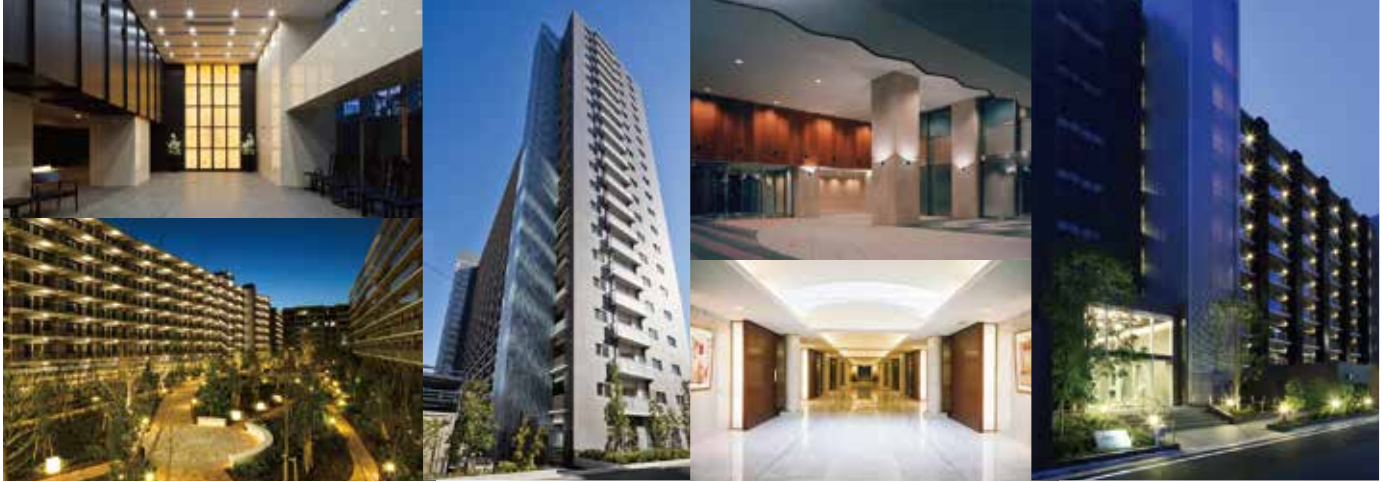
[左上] ザ・グランアルト錦糸町 東京都墨田区 2012年12月竣工(分譲済) [左下] ザ・シーズズ グランアルト越谷レイクタウン 埼玉県越谷市 2015年3月竣工(分譲済) [右] ザ・グランアルト錦糸町 東京都墨田区 2012年12月竣工(分譲済)
